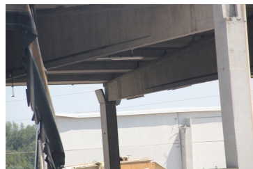
Ligação viga-pilar
