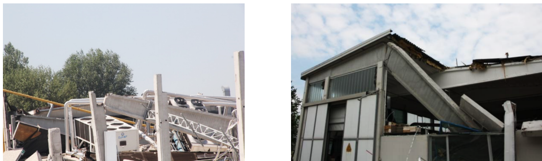
Figura 1. Perda de suporte da viga devido à falha da ligação viga-pilar
